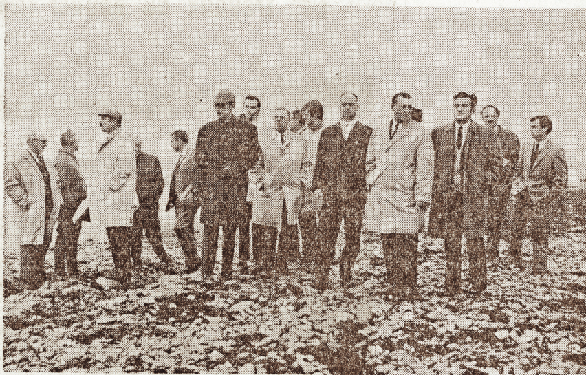
PLEUBIAN. — Les personnalités se rendent compte sur place des travaux à effectuer. (Photo « Télégramme »)
